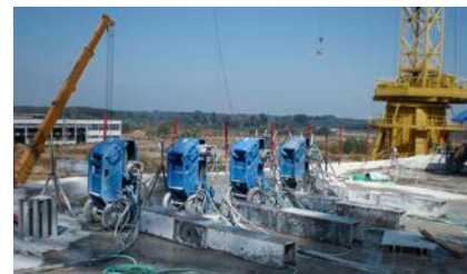
3 BULGARIEN, Belene Rückbau Kernkraftwerk
