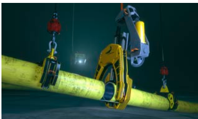
1 USA, Golf von Mexico Unterwasser-Schneidarbeiten
