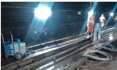
4 GROSSBRITANNIEN, Glasgow Renovierung Glasgow Queen Street Tunnel
