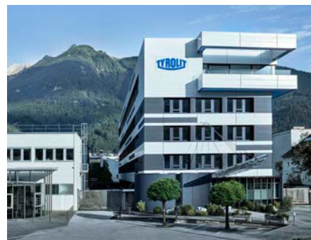
Hoofdkantoor van TYROLIT in Schwaz (Oostenrijk)
