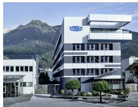
Sede central de Tyrolit en Schwaz (Austria)
