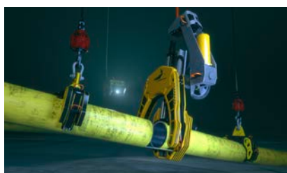
① USA, Golfo del Messico Lavori di taglio subacquei
