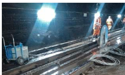
④ GRAN BRETAGNA, Glasgow Ristrutturazione del tunnel Glasgow Queen Street
