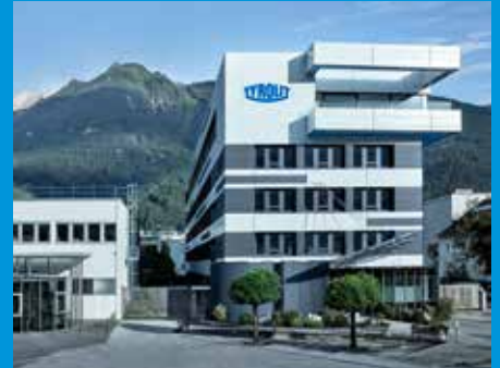
Hoofdkantoor van Tyrolit in Schwaz (Oostenrijk)
