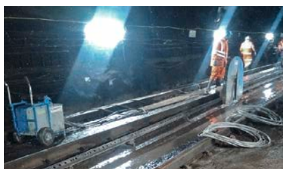
4 GRAN BRETAÑA, Glasgow Renovación del túnel de Queen Street, Glasgow
