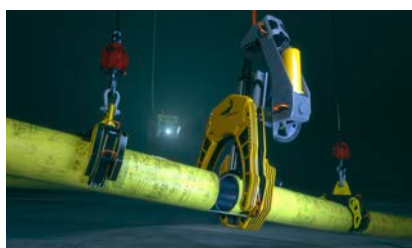
1 EE. UU., Golfo de México Trabajos de corte bajo el agua
