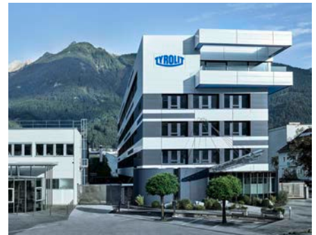
Hoofdkantoor van TYROLIT in Schwaz (Oostenrijk)
