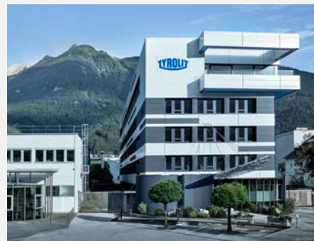
Hoofdkantoor van Tyrolit in Schwaz (Oostenrijk)
