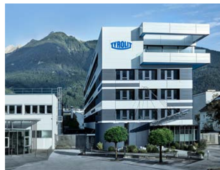
Hoofdkantoor van Tyrolit in Schwaz (Oostenrijk)
