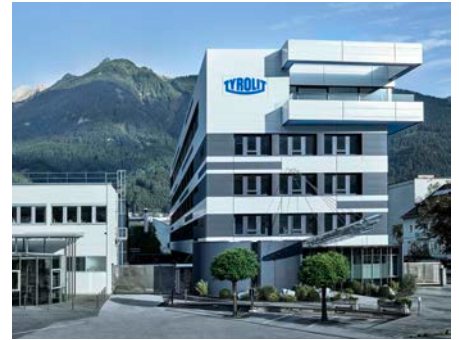
Hoofdkantoor van Tyrolit in Schwaz (Oostenrijk)
